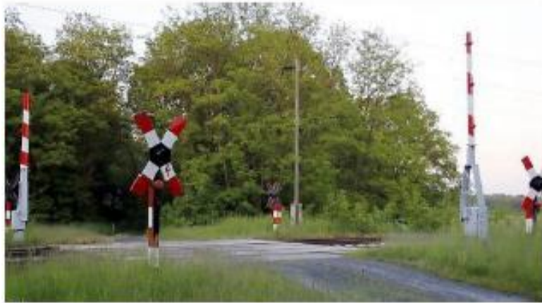
Der Bahnübergang im Mahlsdorfer Grund verbindet die B 96 mit den Agrarflächen und Wäldern hinter der Bahnstrecke.
